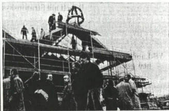
ES WEHTE EIN KÜHLER WIND, als am 5. März vergangenen Jahres das Richtfest für die Nikolausberger Sporthalle von zahlreichen Bürgern des Ortsteils sowie Repräsentanten des öffentlichen Lebens gefeiert wurde.
