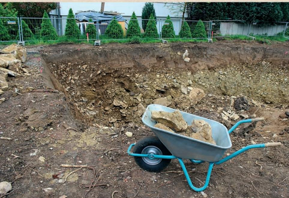
Abb. 6: Typische Nikolausberger Baugrube im Trochitenkalk (Oberer Muschelkalk). Die leicht schräg liegenden Bänke des anstehenden Gesteins sind nur im unteren Bereich der Grube zu erahnen. Darüber liegt eine bis zu 2 m mächtige eiszeitliche Schuttdecke (Fließerde), in die völlig unregelmäßig Gesteinsbruchstücke aller Größenklassen eingeschlossen sind. Darauf folgt ca. 1 m Löss, eiszeitlicher Flugstaub, der zuoberst durch die Bodenbildung (Humus) dunkel gefärbt ist.
