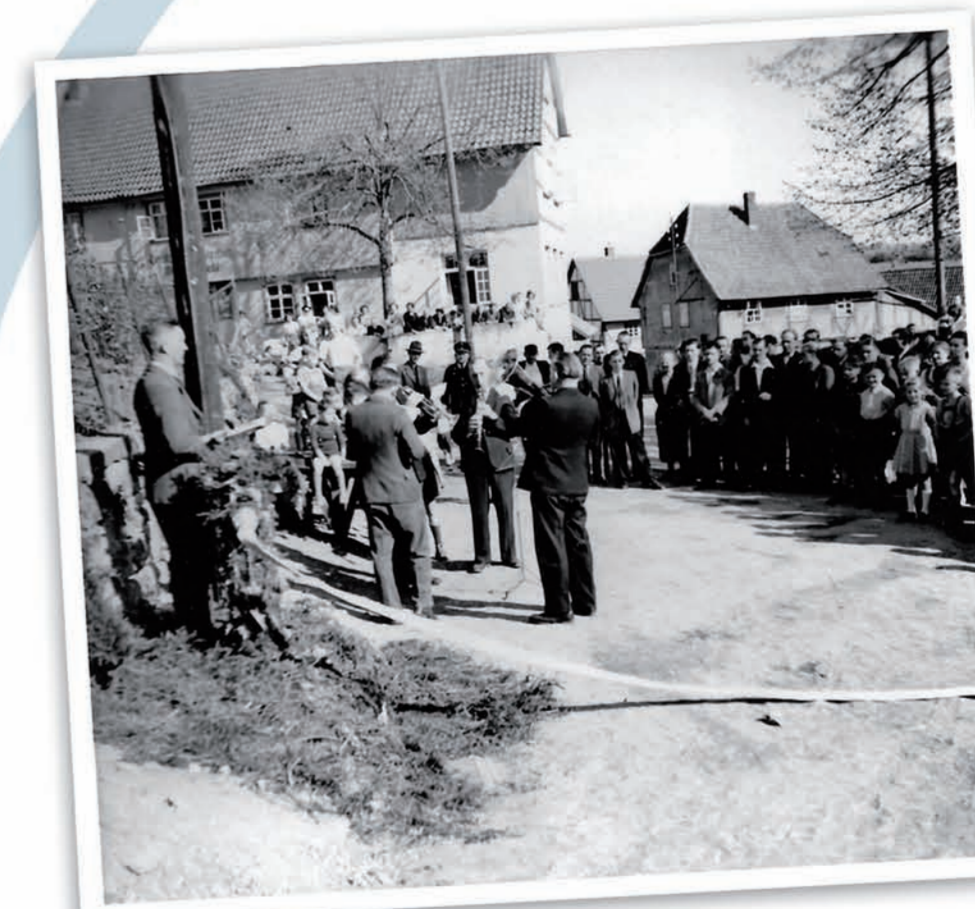
Rechts: Dorfbewohner beim Ausschachten eines Grabens für die Wasserleitung, 1950. Oben: Einweihung der ersten Wasserleitung. Der Hydrant als Rednerpult, im Vordergrund ein beim Probeinsatz geplatzter Feuerweherschlauch.
